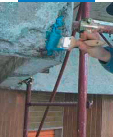
Aplicarea Mapefer 1K cu o pensulă peste barele de armătură la un balcon din beton armat
